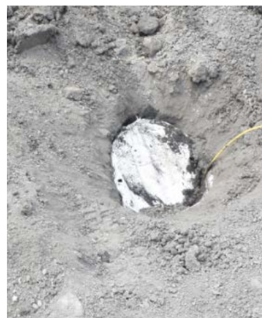
Рис. 7. РЗУ в скважине
